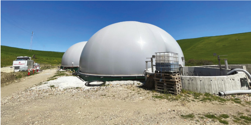
Fig. 12 - Accumulatori dell'impianto di biogas dell'azienda Agricola Puccia.
